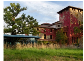
Figuur 17. Hotel-restaurant Troisgros
